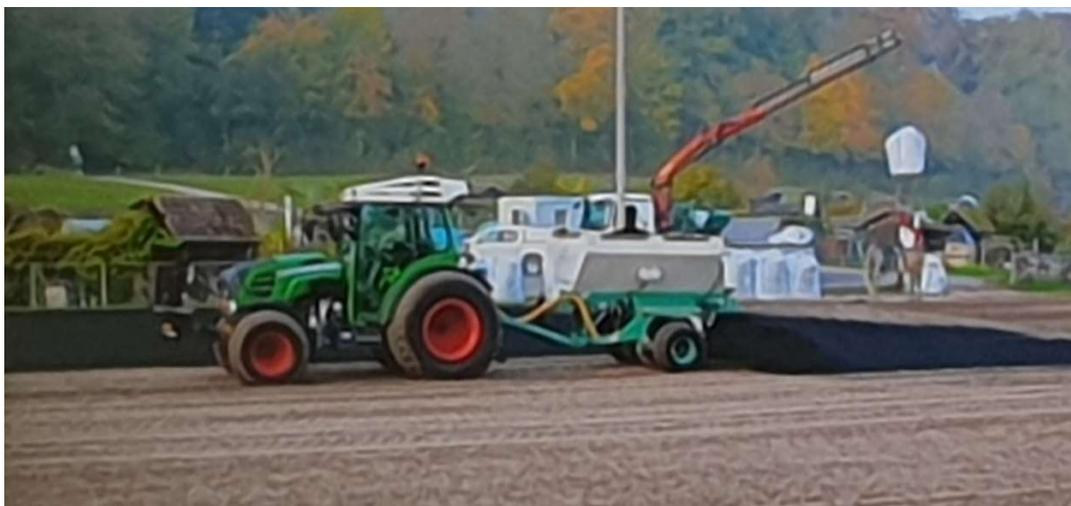
Das obige Bild zeigt das Ausbringen der Pflanzenkohle auf die Fläche eines Fußballplatzes. Danach wurde die Pflanzenkohle mittels einer Bodenfräse mit der oberen Bodenschicht vermischt.
