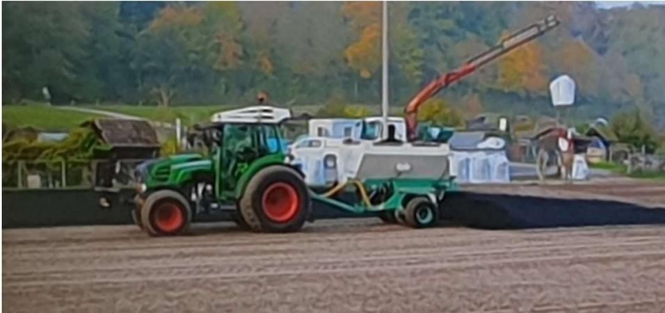
*Bild 3: Ausbringen von Biokohle bei der Anlage eines Fußballplatzes*
